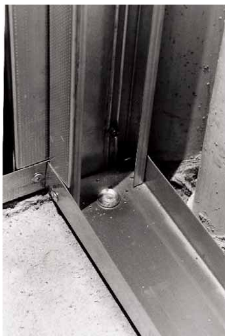
Figura 4.6 – Ancoragem provisória.
