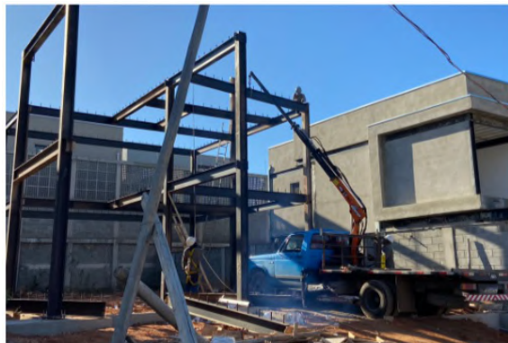
Figura 9.3 – Montagem de Estruturas Metálicas.
