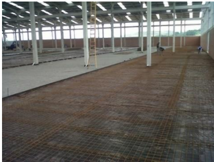
Figura 3 piso concreto armado
