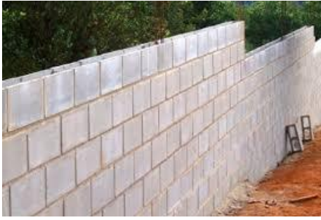
Figura 2 alvenaria de vedação bloco de concreto
