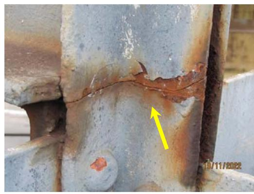
Figura 13 - **Ruptura** de elemento e corrosão na área do dano.
