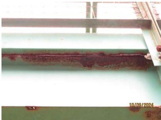
Figura 2 - **Corrosão uniforme** intensa de aço exposto em regiões localizadas de união entre elementos e quinas de elemento revestido
