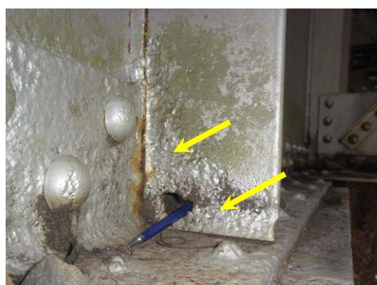
Figura 9 - **Corrosão em fresta** ao longo da união de elementos de aço revestido, formando uma fresta. Observa-se uma **corrosão perforante**.
