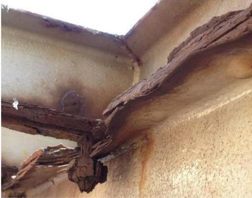
Figura 3 - **Corrosão severa** em aço exposto em regiões de quinas e elementos de fixação.
