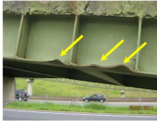
Figura 15 - **Deformação** por impacto de elemento e corrosão na área do dano.
