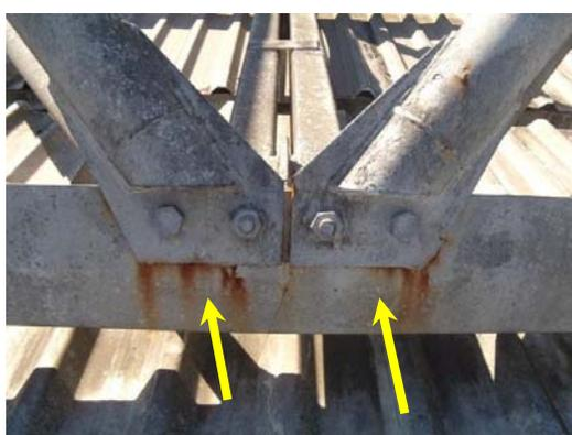
Figura 8 - **Corrosão em fresta** com manchas de escoamento dos produtos de corrosão do aço a partir da união de elementos.
