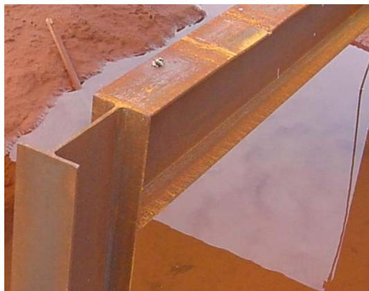
Figura 1 - **Corrosão uniforme** de baixa intensidade ao longo de aço sem revestimento.
