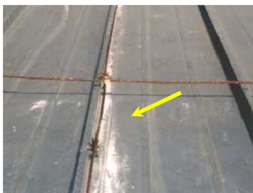
Figura 11 - **Corrosão por deslocamento galvânico** do revestimento de zinco em contato com depósito de produtos de corrosão do cabo de cobre de sistema de aterramento.
