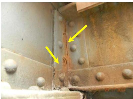
Figura 12 - **Ruptura** de rebite e de cantoneira de ligação e corrosão na área do dano.
