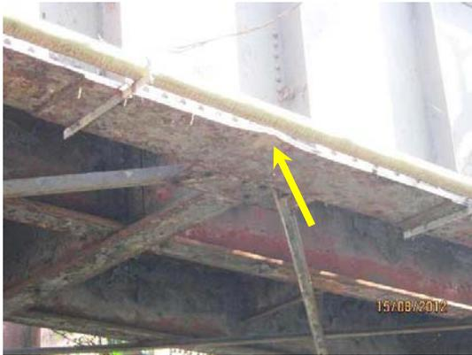
Figura 14 - **Deformação** por esforços não previstos e corrosão ao longo dos elementos.
