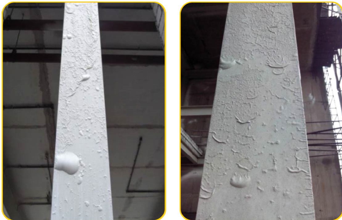
Figura 2 – Exemplo de revestimento acrílico exposto ao intemperismo
